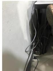
Se evidencia falta de canalización del cableado electrico en los puestos de trabajo por lo que se recomienda la canalización respectiva para mejorar condiciones de trabajo
