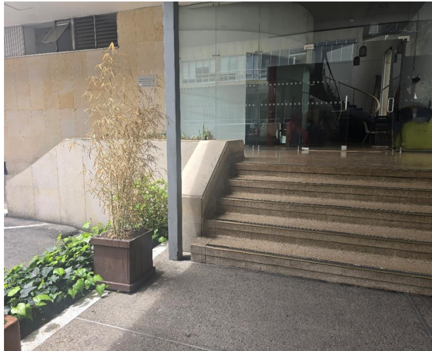
Imagen No. 3. Acceso al Bloque F.
