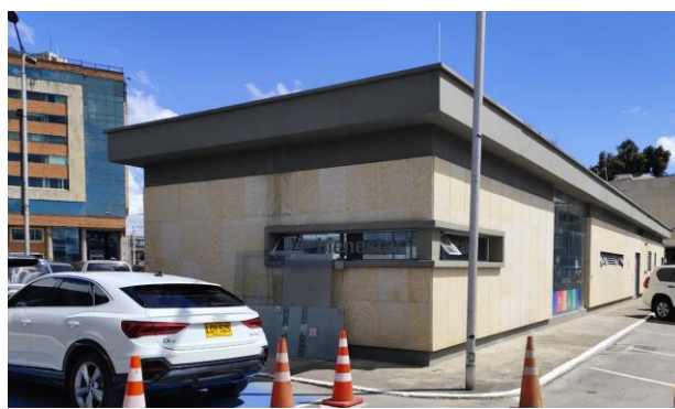
Vista costado sur y occidente
