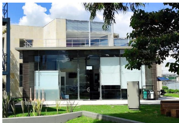
Vista costado oriental
